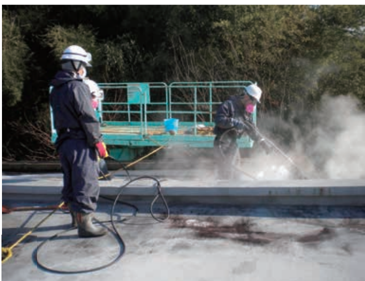
校舎屋上除染作業
