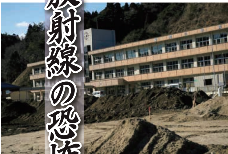
校庭表土除去作業
