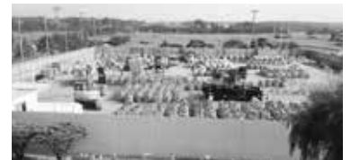
校庭に埋めていた表土の搬出 (パイロット輸送)の様子
