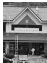
震災当時の本校の被害の様子
